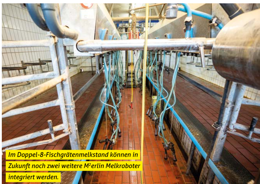
Zwei M 2 erlin Melkroboter wurden direkt an das Stallgebäude integriert
